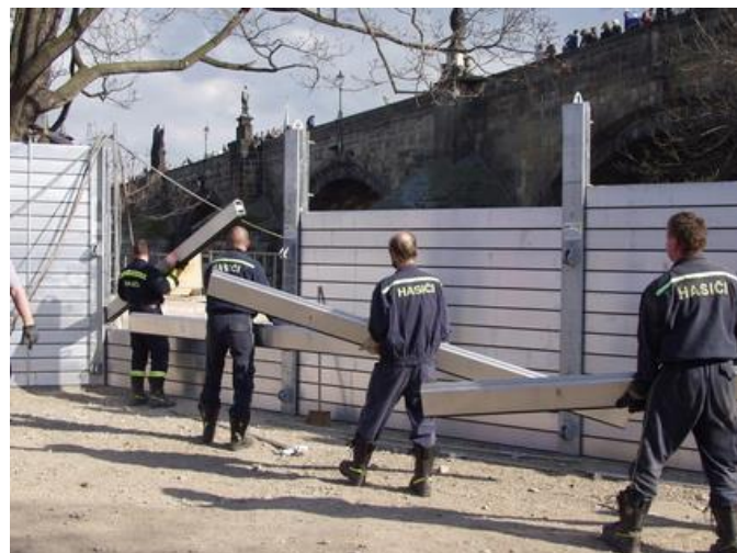
Foto 12.3. Ajutise veetõkke sein paigaldamine Prahlas (Foto: Google)
