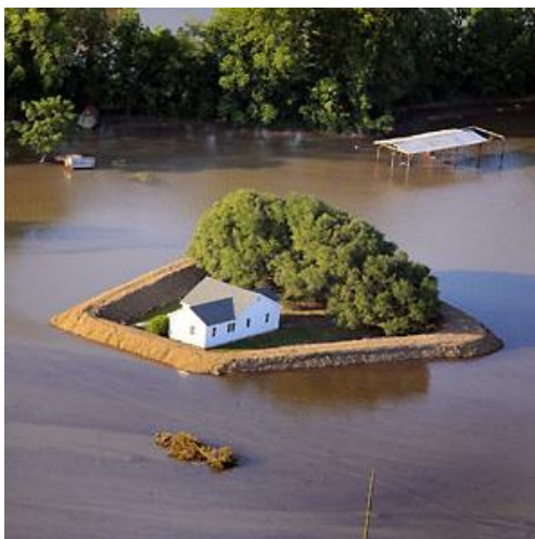
Foto 12.5. Kaitsetamm üksikobjekti kaitseks (Foto: Google)
