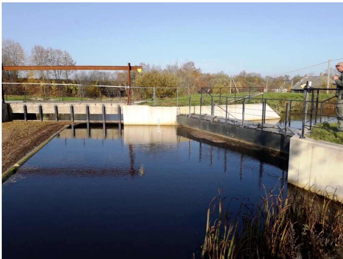
Foto 3 Sillaoru HEJ pealevoolukanali võresõlm, piidega võre 8,45x2,7 m on vee all, nähtav on võre kohal teraslehest prahitõke.
