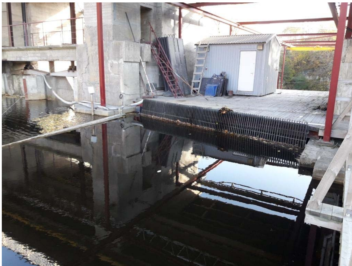
Foto 2 Kunda III (IMG) HEJ sissevoolu võresõlm, piidega võre 7,1x4 m.
