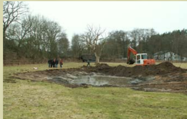
Nygravning af vandhul. Bemærk de svagt skrånende bredder.
